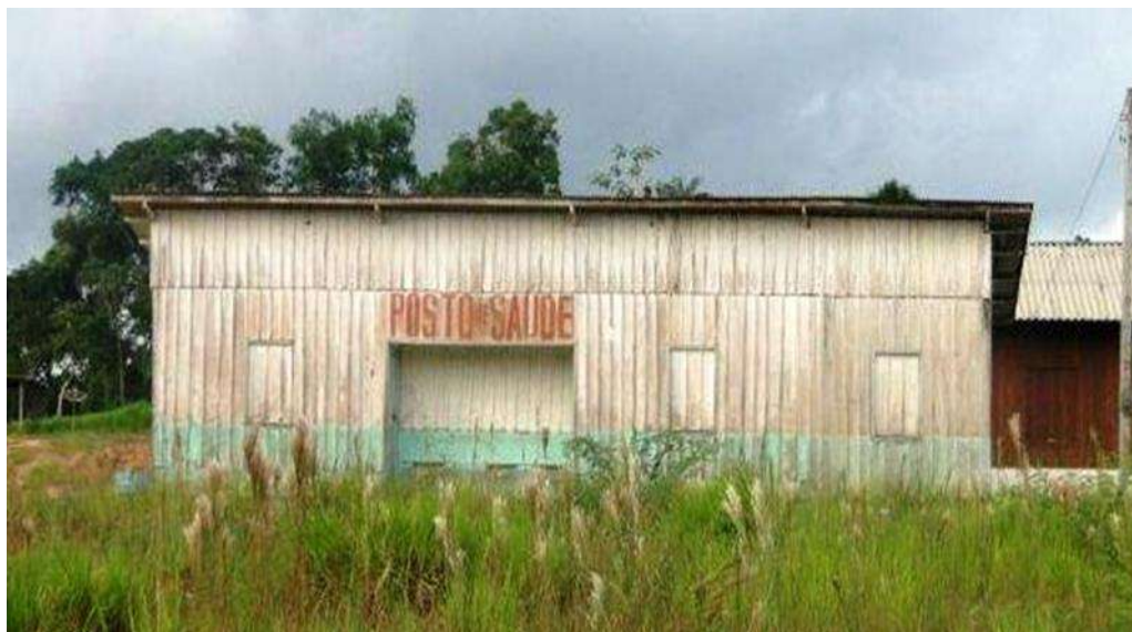
Figura 25: Posto de Saúde da FEL, localizado próximo ao rio Liberdade.
