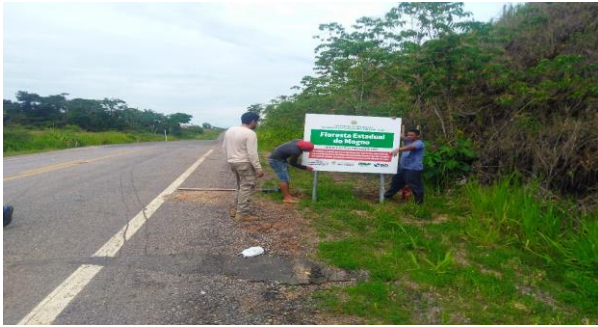
Figura 226. Instalação das placas de sinalização da Floresta Estadual do Mogno
