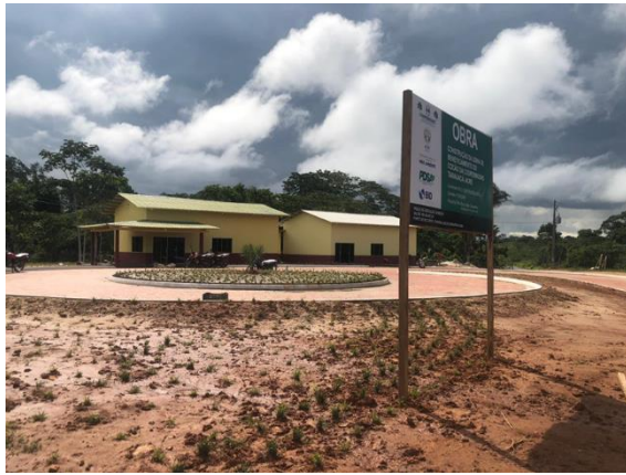
Figura 279. Sede da Coopermogno
