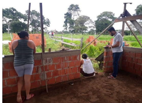
Figura 50 Monitoramento socioambiental na comunidade Riozinho do Andirá no município Bujari
