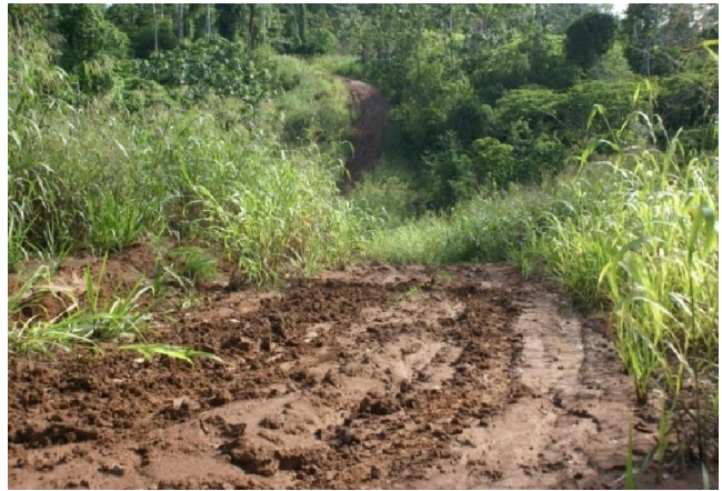
Figura 11. Situação do ramal de acesso ao PA, após chuva (Foto: Jakeline Pinheiro)
