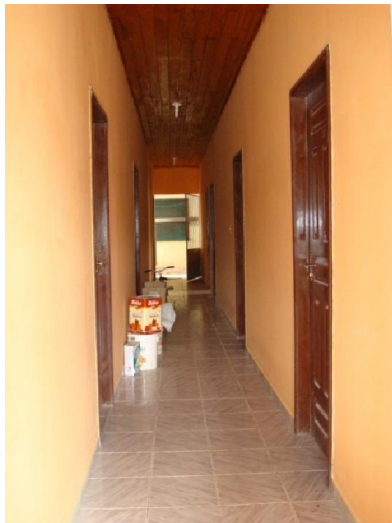
Figura 34. Corredor de acesso aos apartamentos no Hotel Floresta (Foto: Vitória Müller)
