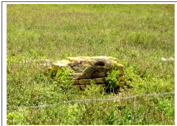
Foto 3.01 – Ruínas de Construção da Época de Frederico Jana no Reentregue (Allegretti, 2009)
